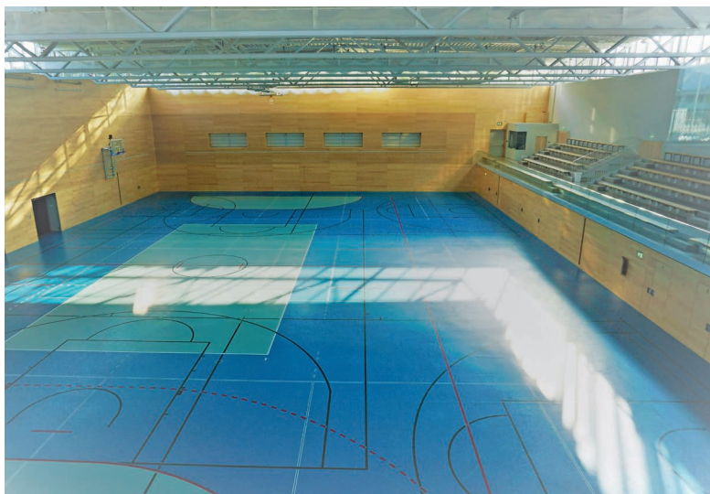
Die erste bauteilaktivierte Plusenergie-Sporthalle Österreichs: das Smart-City-Leuchtturmprojekt Sportzentrum Nord, Salzburg.
